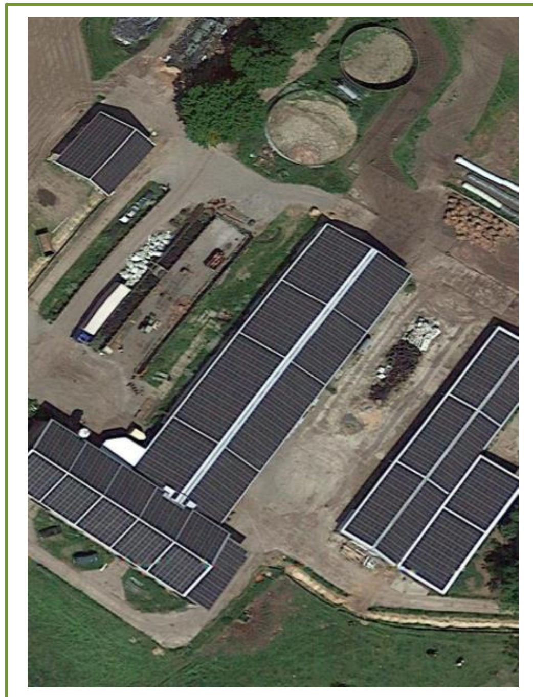
Mehrzweckhalle Groß Rosenberg 268 kWp
