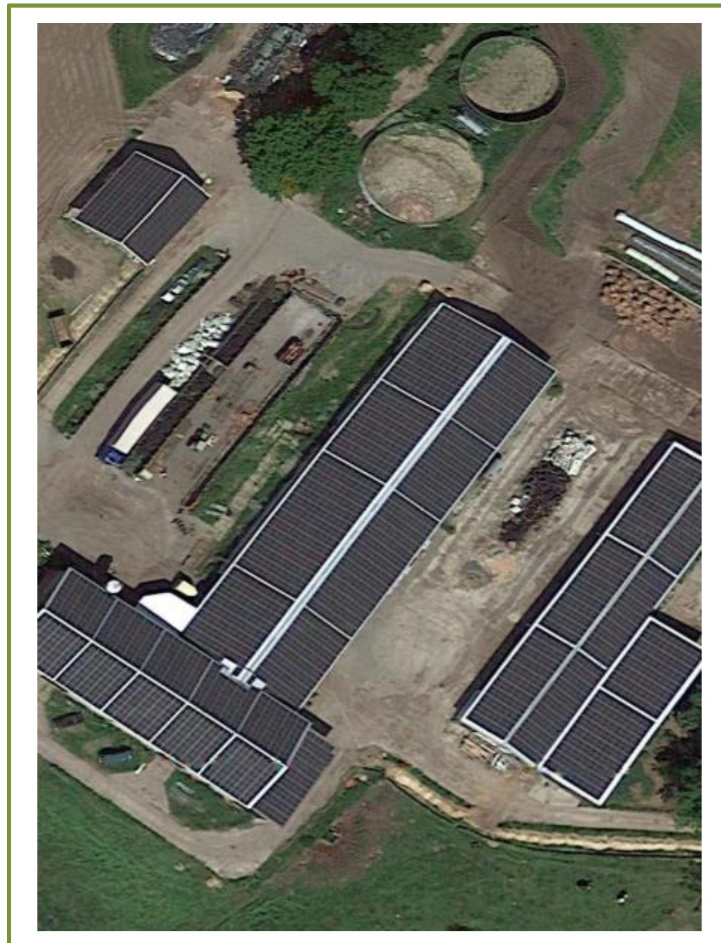
Mehrzweckhalle Groß Rosenberg 268 kWp
