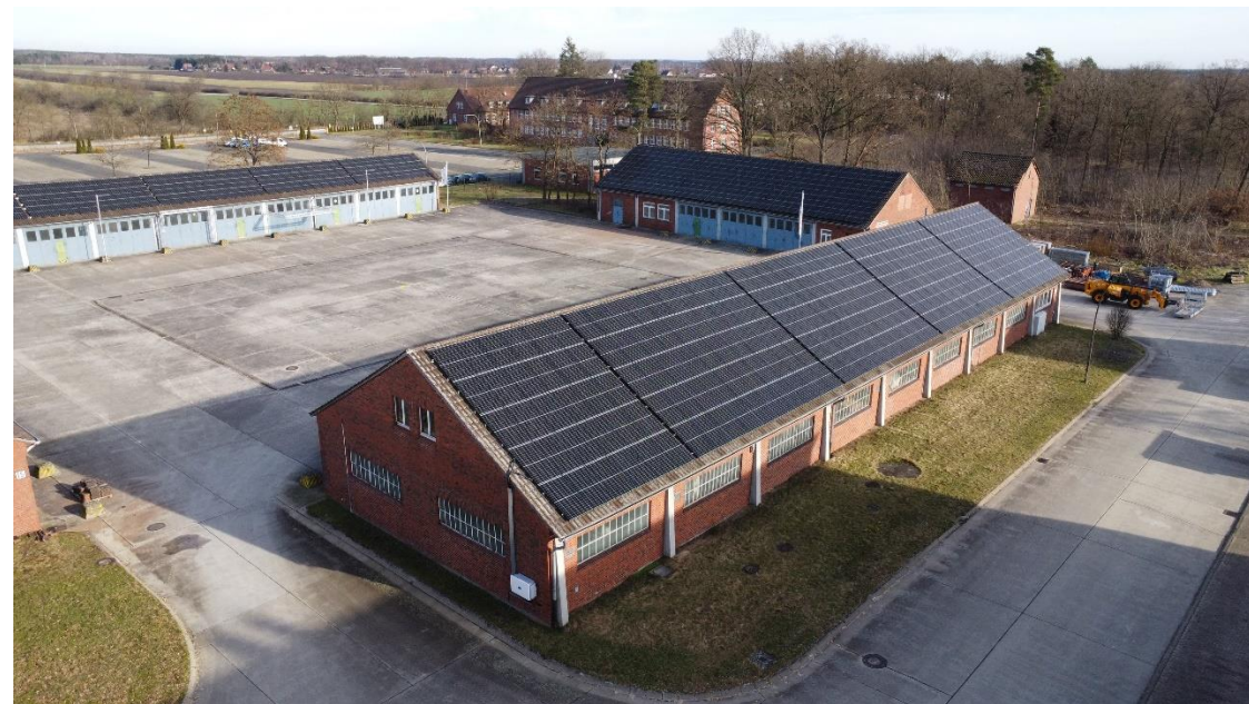
Gewerbepark bei Wesendorf 1.527 kWp auf 10 Dächern
