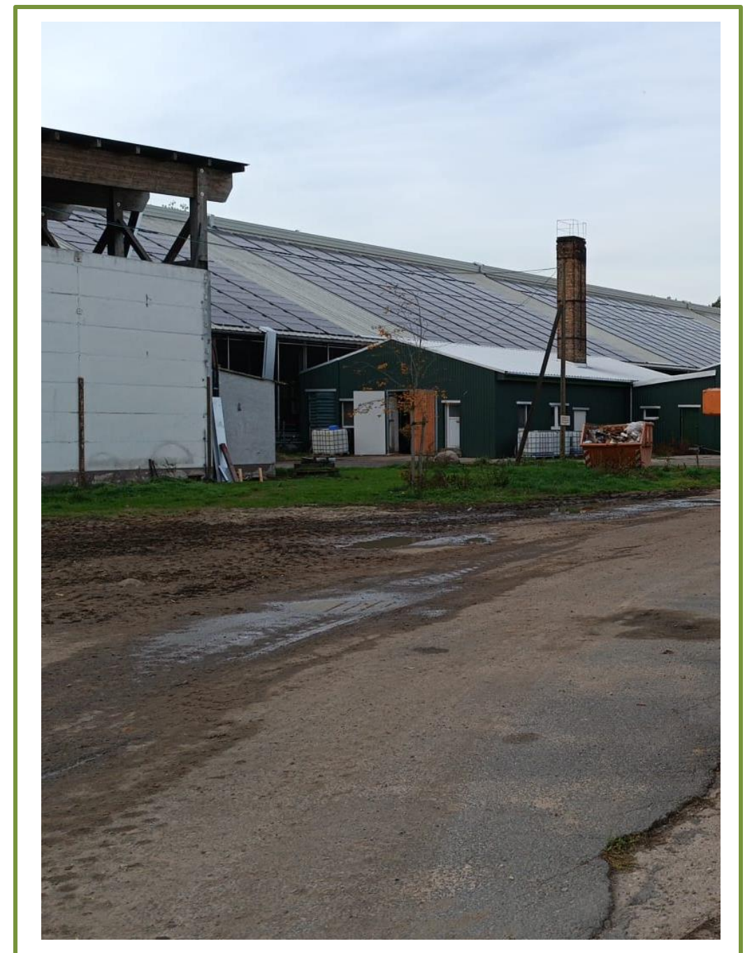
Landwirtschaftlicher Betrieb Nähe Bad Freienwalde 945 kWp
